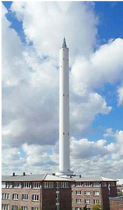
Abb. 4: Der Fallturm in Bremen: In Bremen ist ein Großlabor, in dem Experimente unter Schwerelosigkeit durchgeführt werden. Für 4,74 Sekunden werden Bedingungen geschaffen, wie sie sonst nur zu wesentlich höheren Kosten im Weltraum realisiert werden können. Mit einem Katapultsystem wird die nutzbare Zeit demnächst auf ca. 9 Sek. verdoppelt.(Näheres unter: [http://www.reproteam-bremen.de/fallturm/idx\\_uebersicht.htm](http://www.reproteam-bremen.de/fallturm/idx_uebersicht.htm))
